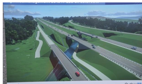
Simulation de corridor sous l'autoroute 85 Source : MTQ
