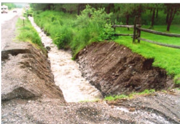
Photographie no 2 : Début de section nettoyée selon la méthode traditionnelle pour les premiers mètres, puis selon la méthode du tiers inférieur pour le reste. La photographie a été prise lors de la période de fortes précipitations de la mi-juillet 1996 et moins d'une semaine après l'intervention de nettoyage du fossé. Remarquer la forte érosion déjà en place dans les premiers mètres alors que la partie creusée selon la méthode du tiers inférieur est demeurée presque intacte. (Route 222-01-120, vue vers le sud-est) (Photo RAPPEL, 96-07-12)
