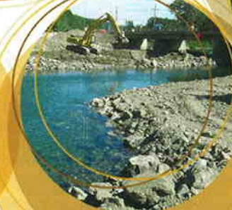
Traverses de cours d'eau (pont, ponceau, passage à gué)
