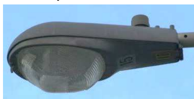
Lampadaire au sodium
