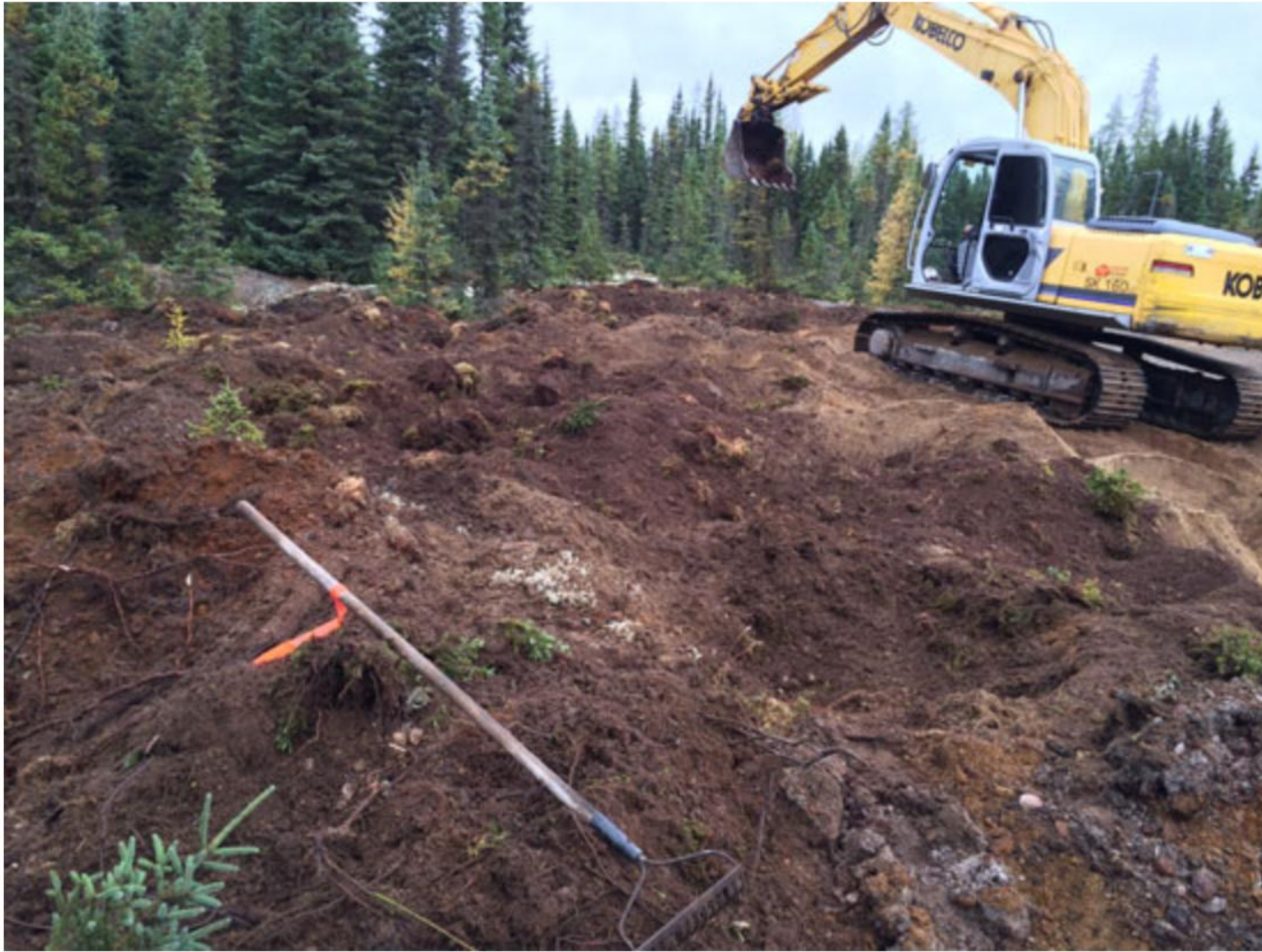
Figure 1. Excavatrice formant des creux et des monticules, Mireille Boulianne
